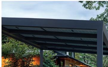
**/ TOITURE EN PENTE DE 10%, POUR L'ÉCOULEMENT DE L'EAU & LA PERFORMANCE DES PANNEAUX**
