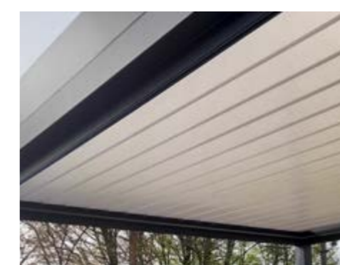
effet toit plat (double paroi des lames)
